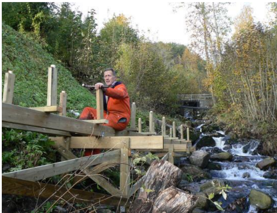
Leiaren i teknisk utval, Svein Stene, i arbeid med renna til kvernhuset.
