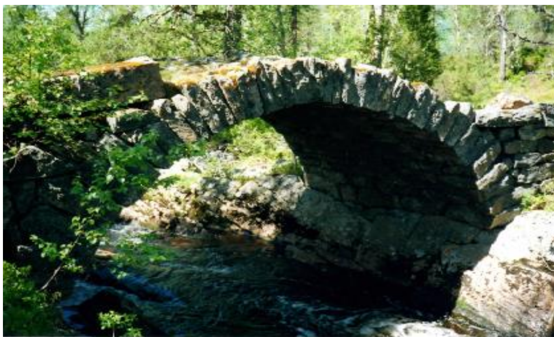
Kvelvingsbrua over Svartløkelva. Foto 07.06.2000
