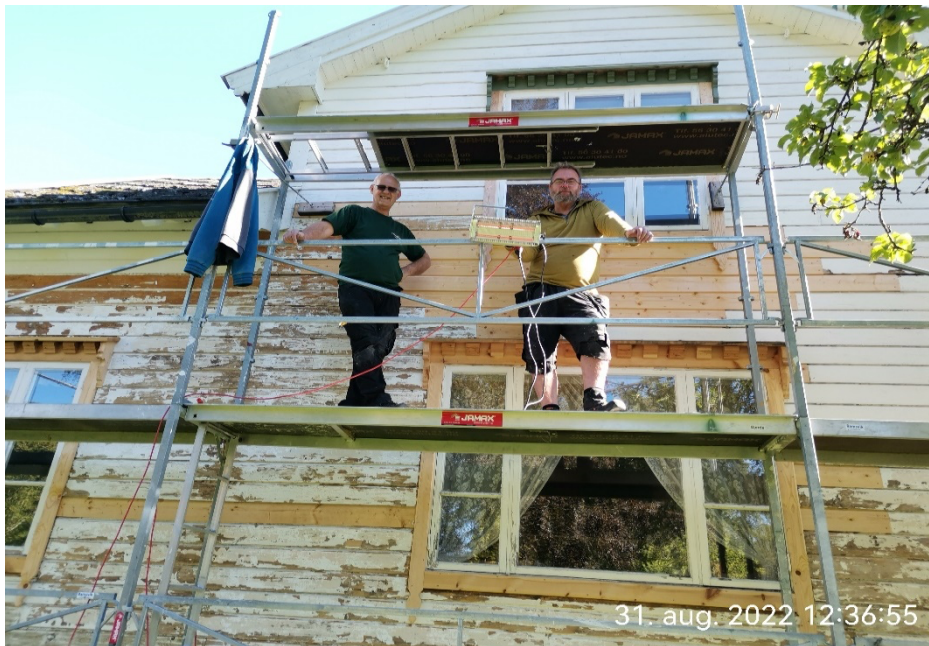
Paktarhuset under renovering – bilete frå 2022.
